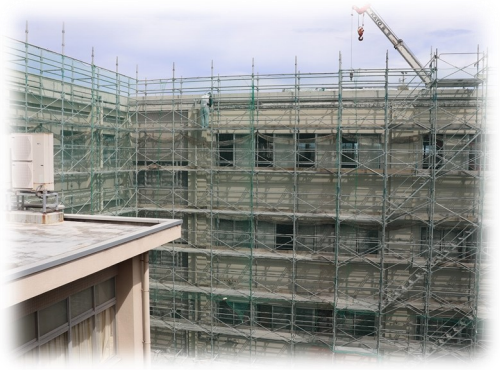
工事中の北校舎
