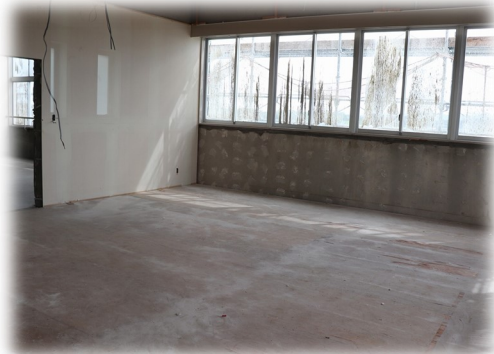
工事中の東校舎
